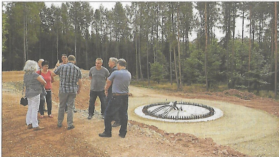
Die Eiterfelder Freie-Wähler-Fraktion bei ihrer Begehung im Buchenauer Wald an einer der Fundamentplatten. Foto: privat
