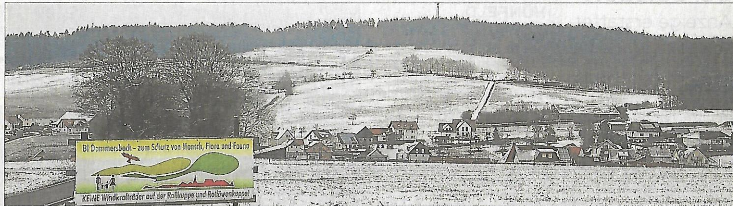
Windkraftstandorte – hier ein Blick auf Dammersbach vor dem Bau der ersten Rotoren – bleiben umstritten. Foto: Volker Nies
