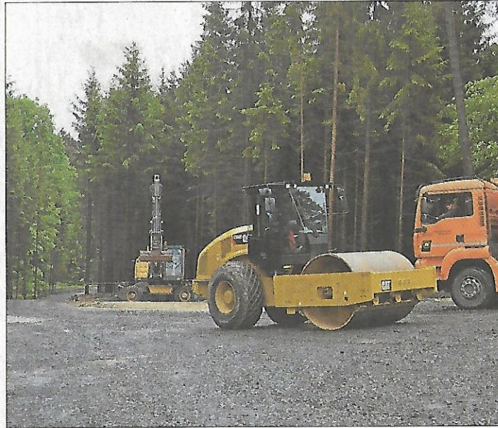
Für den Bau der Windräder wurden zwischen Hofbieber und Hünfeld einige Hektar Wald gerodet. Foto: Volker Nies
