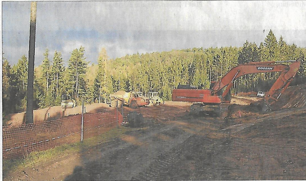
Die Vorarbeiten für die Errichtung der Windräder am Steinberg bei Angersbach haben begonnen. Foto: Hans-Werner Golke
