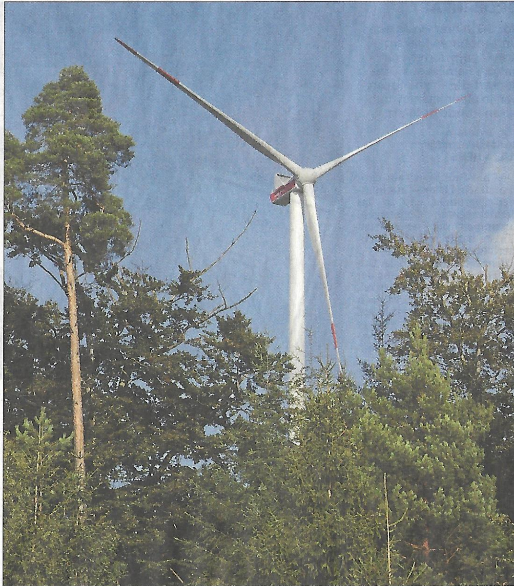
Windparks Wartenberg: Eins der fünf Windräder vom Typ Vestas V112 mit einer Leistung von 3,3 Megawatt und einer Nabenhöhe von 140 Metern. Foto: Norman Zellmer
