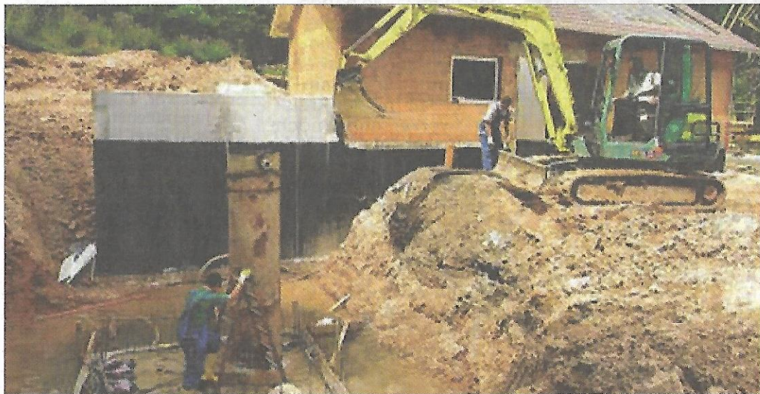
Die Rothenkirchener Hochbehälter-Baustelle im Jahr 2001. Jetzt, 2018, werden Rechte für das Verlegen der Wasserleitungen im Wald vertraglich geregelt. Foto: Karl-Heinz Burkhardt
